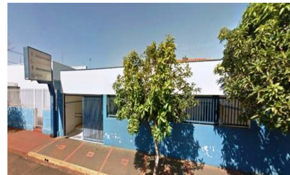
Prédio da Ajunta Militar localizado na R. Inácio Franco n° 736.
